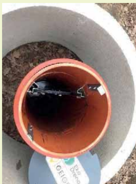
Abbildung 2: Schacht mit Anstauklappen in der Mitte (Draufsicht)
