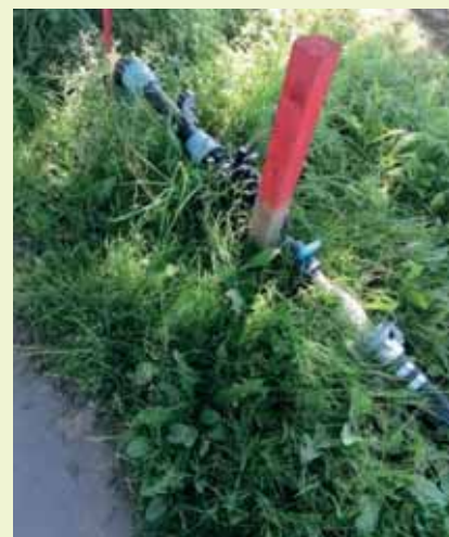
Abbildung 2: Anschluss an einen Hydranten (Hendrik Roosmann)
