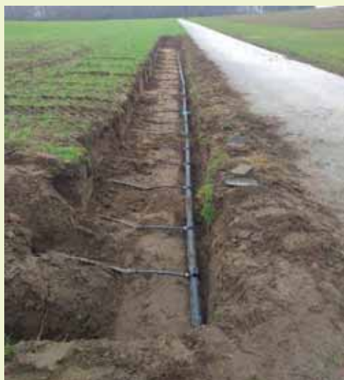
Abbildung 1: Verlegte Bewässerungsschläuche (Pascal Gerbaulet)
