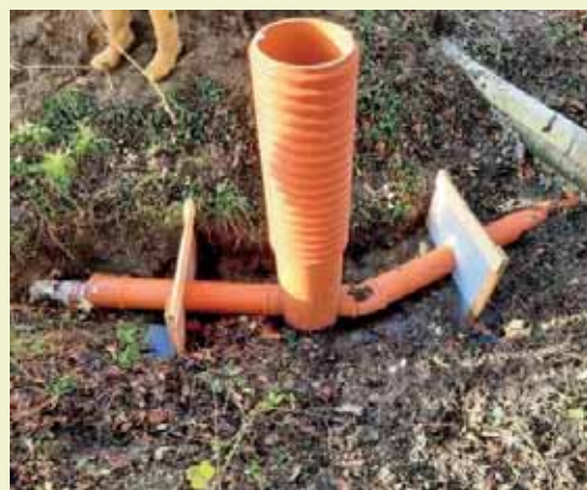
Abbildung 1: Schacht (mittig), Drainagesammler (links), Ablauf in den Graben (rechts), nach dem Einbau, vor dem Verfüllen
