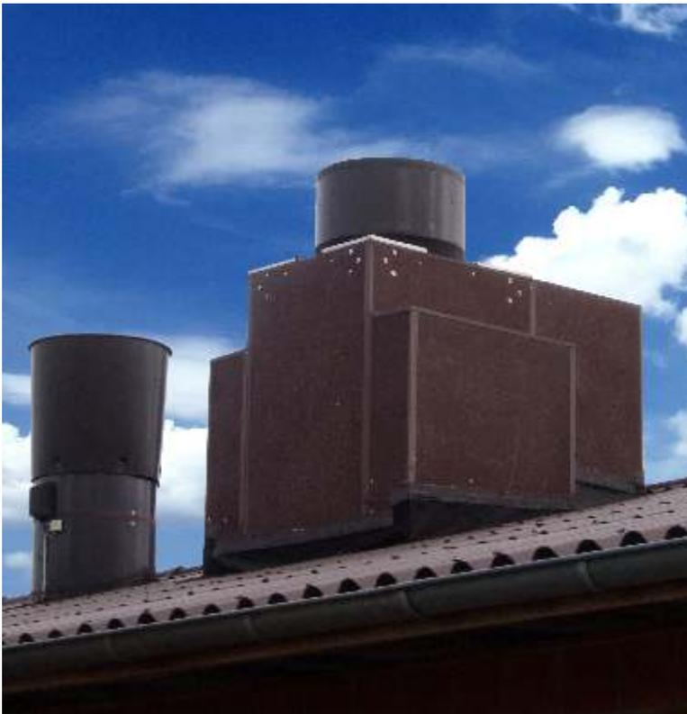
In Versuchen mit unterschiedlichen Techniken zur Abluftreinigung, werden die Möglichkeiten zur Reduktion von Stickstoffemissionen aus der Tierhaltung erprobt.
