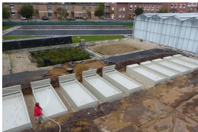
Abb. 14: Einbau der neuen Behälter
